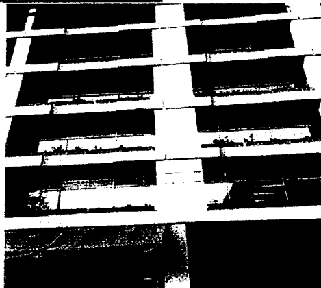
Fachada frontal (diferente toma) donde se ubican las 81 jardineras, distribuidas entre pisos.
