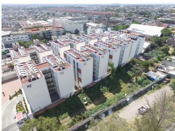
Cabo Finisterre No. 115 (1ra y 2da Etapas)
